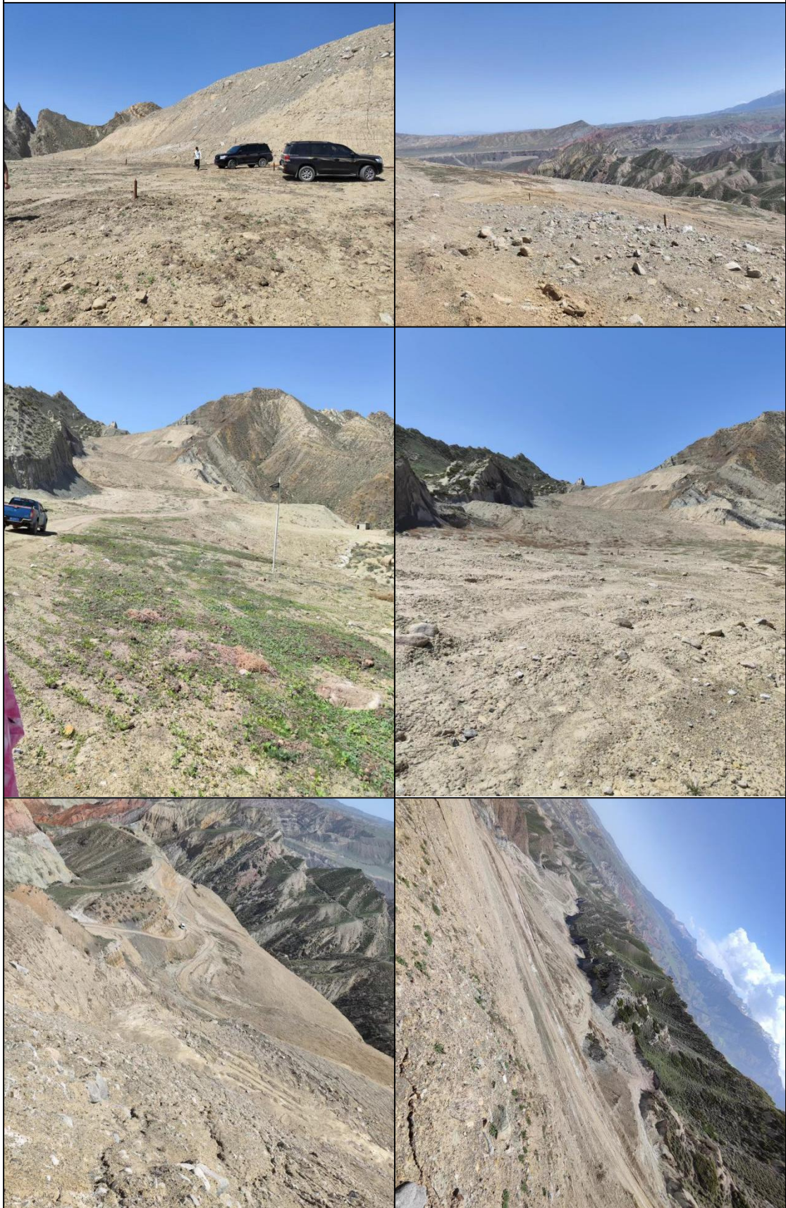
乌苏四棵树煤田火区灭火工程现场图
